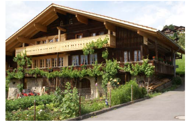
20 Bäuerliches Wohnhaus, wohl anfangs 17. Jh., renoviert 2010/11
